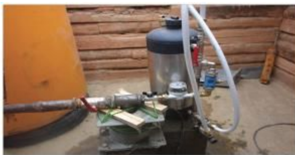
Монголия, пустыня Гоби. Индивидуальные системы очистки. Пуско-наладка.
